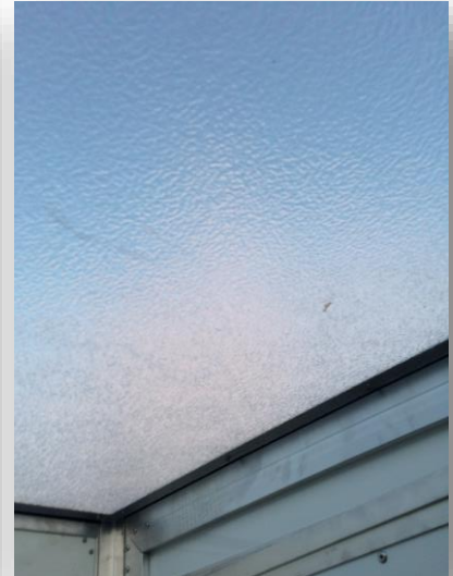
Dach aus Lichtdurchlässigem Kunststoff
